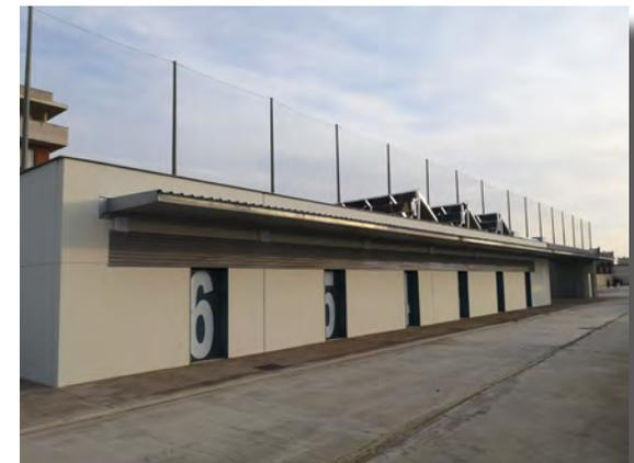
El edificio se ha diseñado con un sistema constructivo industrializado gracias al cual se ha realizado el montaje de la estructura, pilares, forjados y las fachadas en solo 3 semanas.
