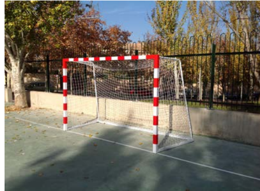
Detalle de portería con anclajes
